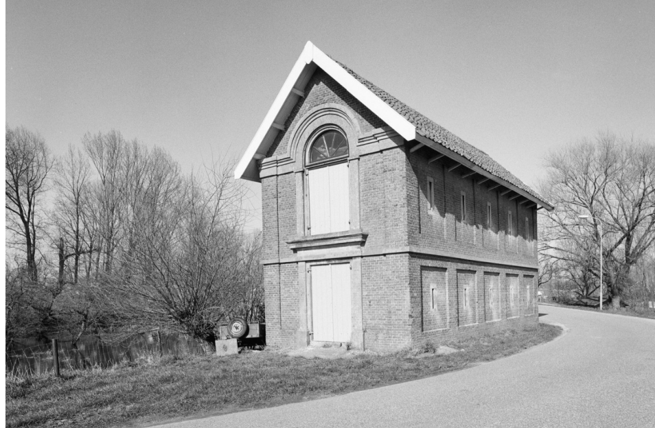
Dijkmagazijn aan de Vluchtheuvelstraat in Dreumel in 1995. >> © P. van Galen, Collectie Rijksdienst voor het Cultureel Erfgoed.
