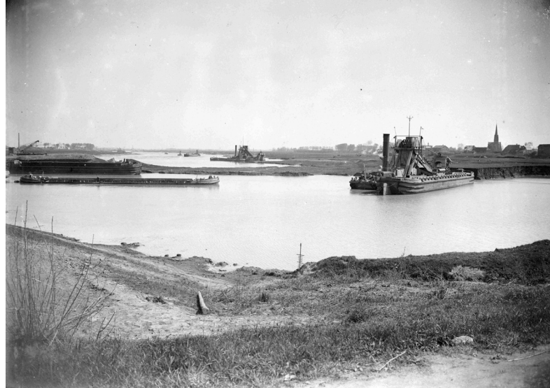
Baggermolen vormt een zandput in de Uiterwaarden langs de Waal, waarschijnlijk bij Millingen aan de Rijn. Foto van omstreeks 1950.
