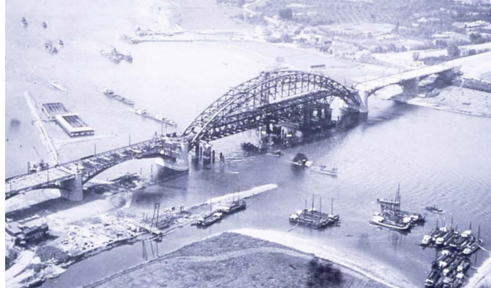
Waalbrug in aanbouw, omstreeks 1935.
