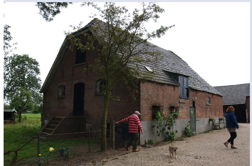
Vloedschuur met verhoogde stalfvloer bij IJzendoorn. De vloedschuur wordt veranderd in woning met theehuis. >> © Ferdinand van Hemmen.
